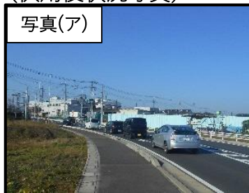
(供用後状況写真)
