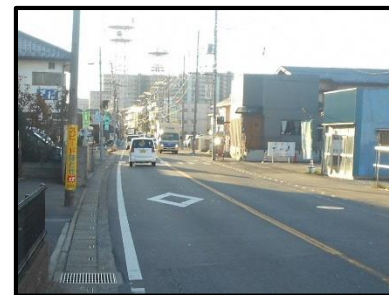
写真(イ) (供用後、国道122号)
