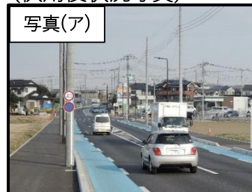
(供用後状況写真)
