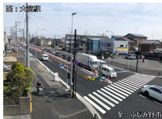
完成後【平成31年3月】撮影
