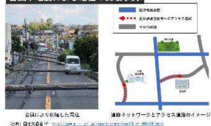
台風や地震による電柱の倒壊事例
