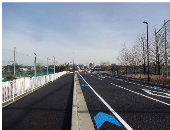
矢羽根形状の路面表示を設置した事例 (説明会時未掲載)
