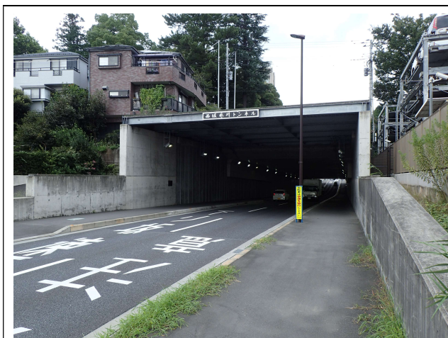
西堀氷川トンネル (桜区)
