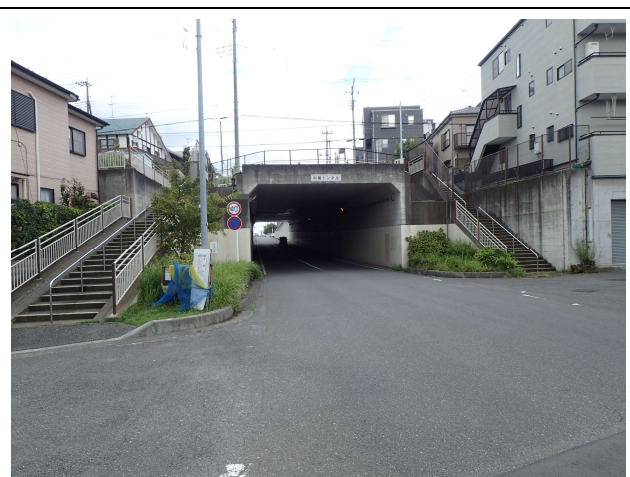
中尾トンネル (緑区)
