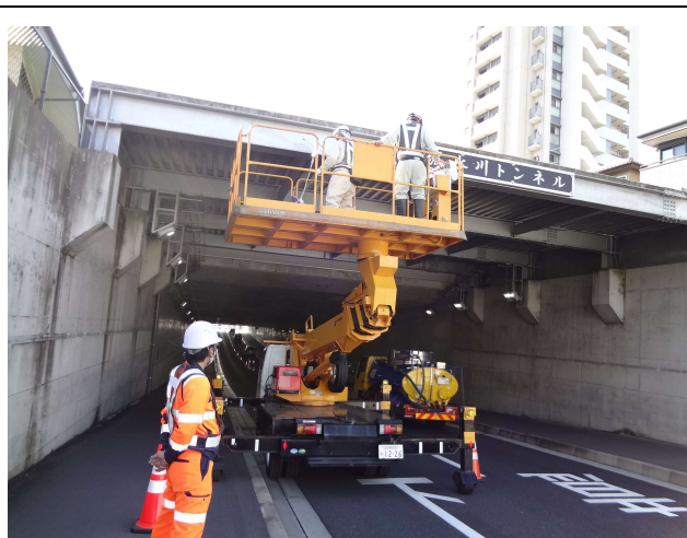
高所作業車を使用した近接目視点検 (西堀氷川トンネル)
