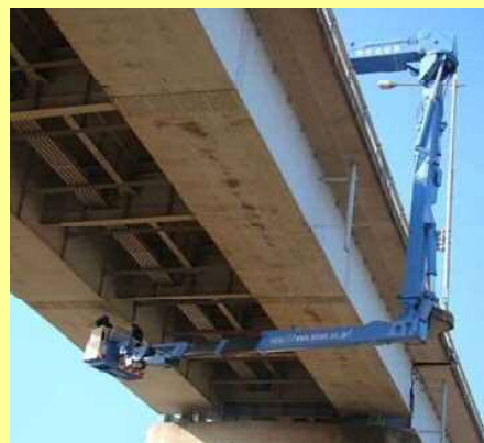
橋梁点検車を使った点検
