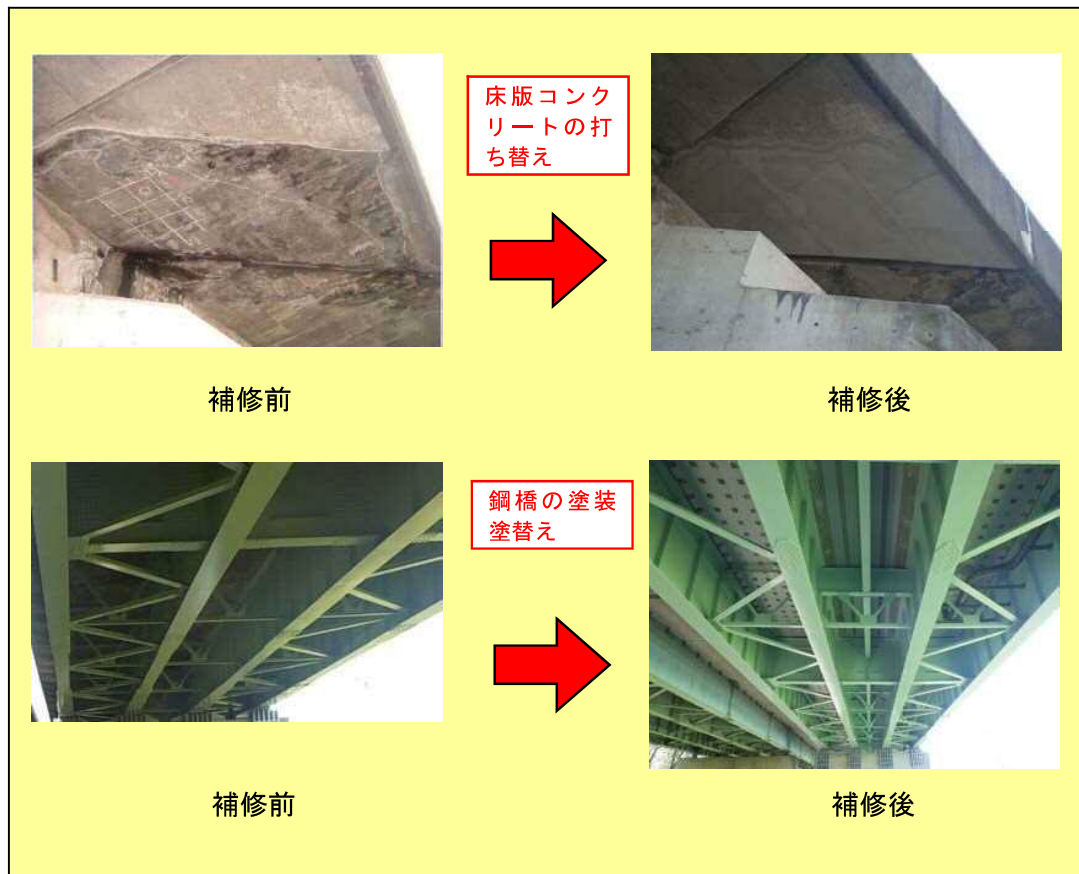
緊急補修を行った橋梁
