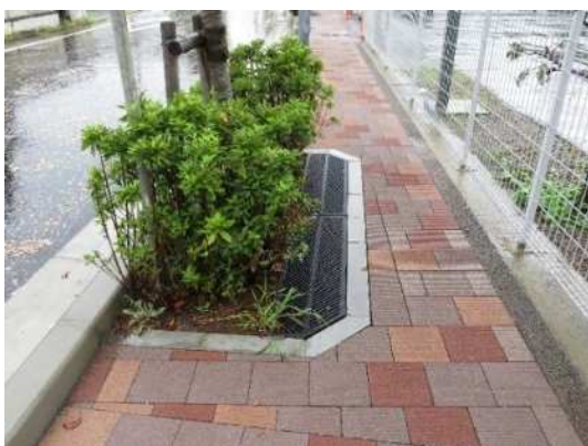
老木化した街路樹を更新し、踏圧防止版を設置し有効幅員を確保した例（横浜市）
