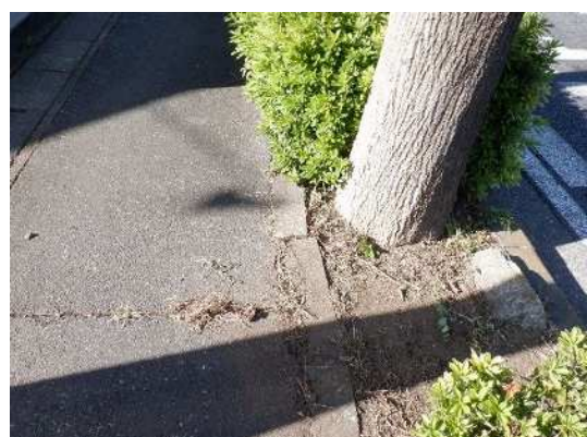
根上りによる亀裂
