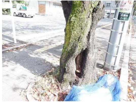
幹の腐朽の発生 (市道 10709 号線外、宮原駅前通り)
