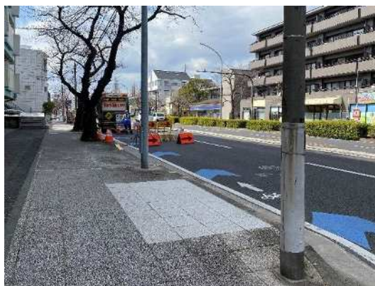
老木化した街路樹を一部撤去し再舗装した例 (横浜市)
