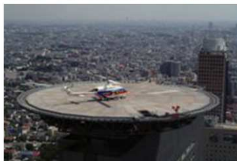
ヘリポート(さいたま新都心合同庁舎2号館)
