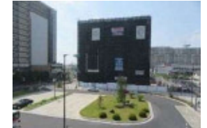
建設中の集合住宅
