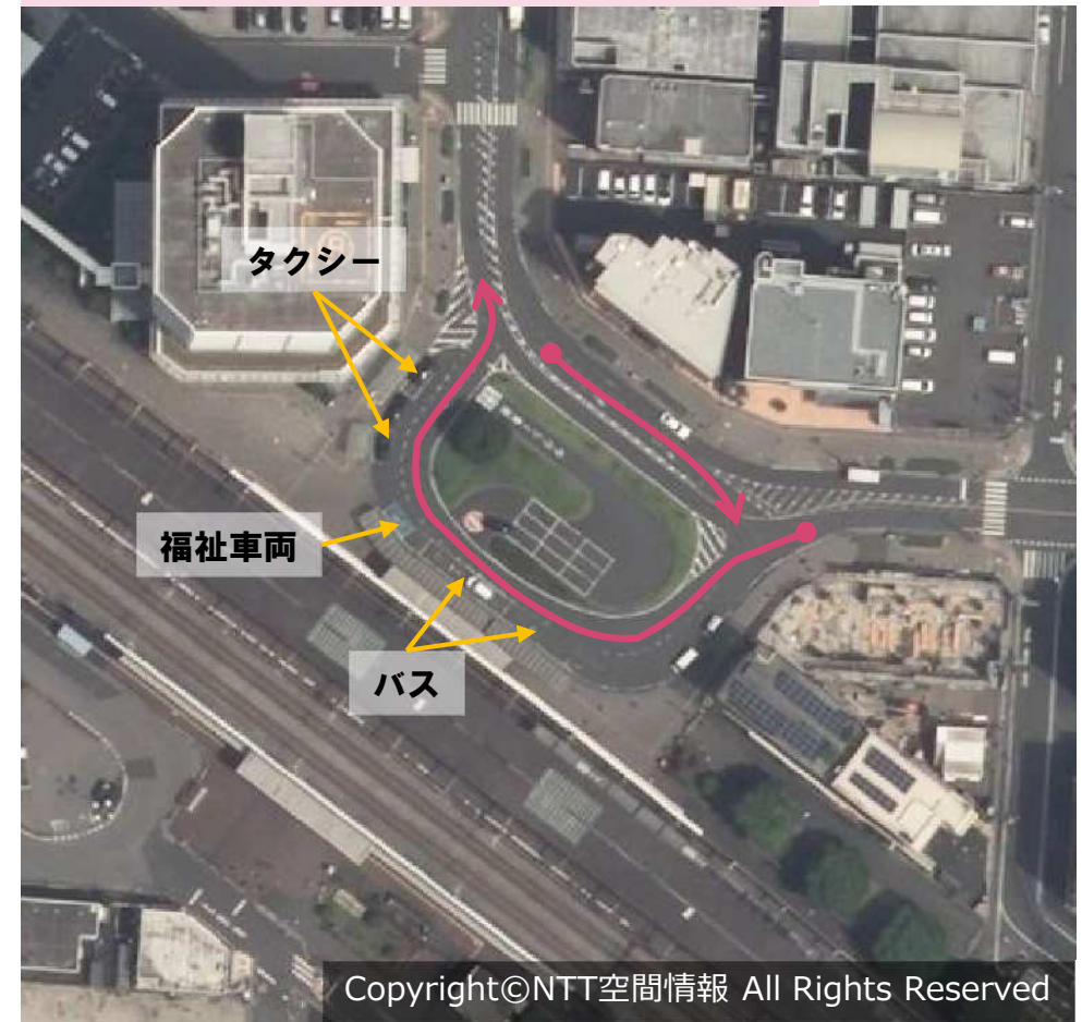
JR埼京線：北戸田駅東口 (3,200㎡)
