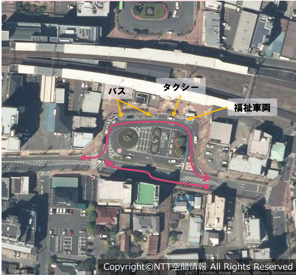
JR武蔵野線：吉川駅南口 (3,500㎡)
