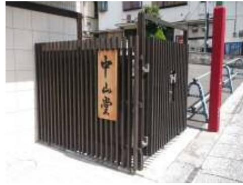
ゴミ箱や、無電柱化に伴う地上機器に格子の目隠しを設置し、景観に配慮している。
