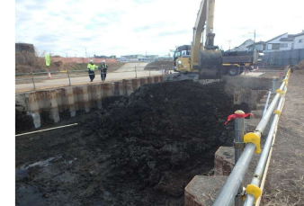
(鋼矢板内の床掘)
