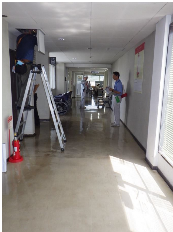
現地踏査作業風景（点検口の確認）
