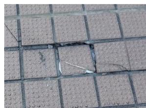
写真.3 簡易補修後の建材
