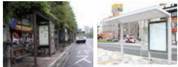
バスシェルターの事例 (左：岡山) 街並みに配慮したデザイン、(右：浦和駅) 広告付き
