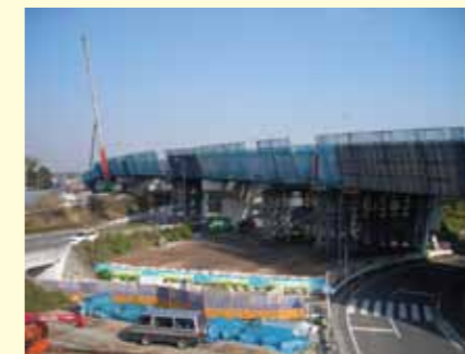
整備が進む上尾バイパス線
