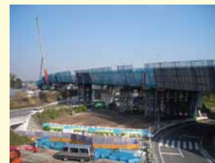
整備が進む上尾バイパス線
