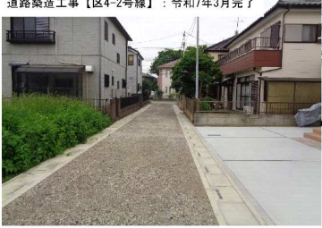
道路築造工事【区4-2号線】：令和7年3月完了
