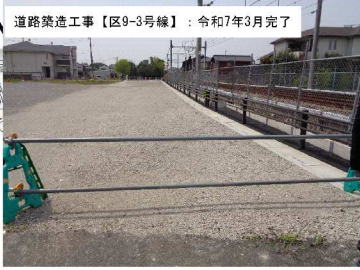
道路築造工事【区9-3号線】：令和7年3月完了
