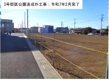
3号街区公園造成外工事：令和7年2月完了
