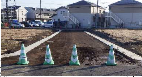
側溝工事【区6-6号線】：令和5年3月完了
