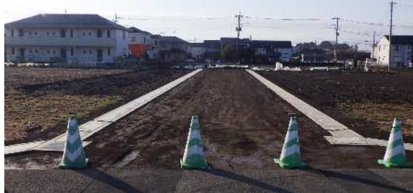
側溝工事【区6-33号線】：令和5年3月完了
