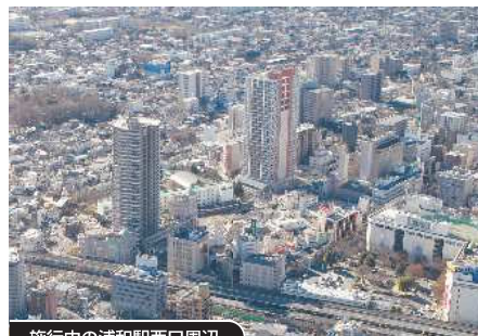
施行中の浦和駅西口周辺
