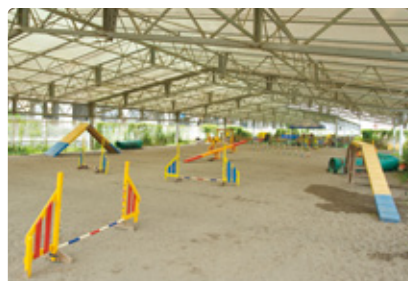
D さいたま市桜区西堀8丁目地内
