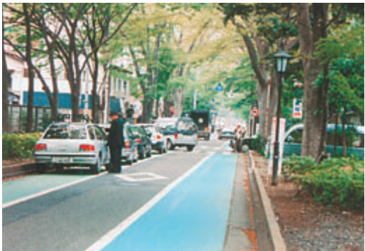
▶工事前の氷川参道。歩道がなく、加えて違法駐車や交通渋滞が絶えず、歩行者にとって危険な状態でした。
