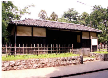
三の丸内の城主居室の構えの門だといわれている「岩槻城城門(黒門)」。
