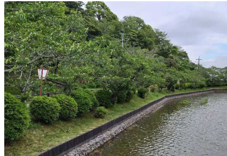
某公園（擬木+カゴマット）
