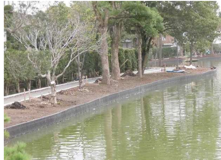
某公園（擬木護岸）
