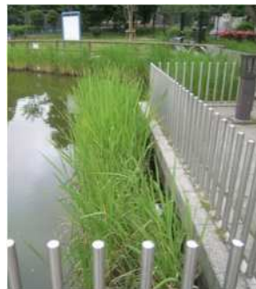
図 - 施工事例写真
