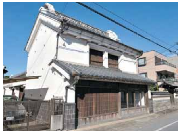
④ 長谷川邸の土蔵造り 所在地：岩槻区本町3-5-25
