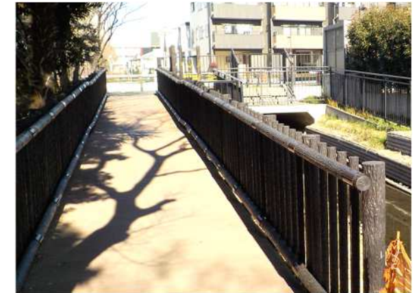
プラ擬木柵の整備例(高沼用水路)
