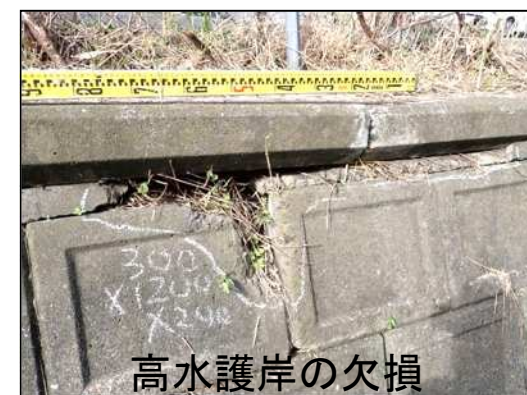
高水護岸の沈下・転倒
