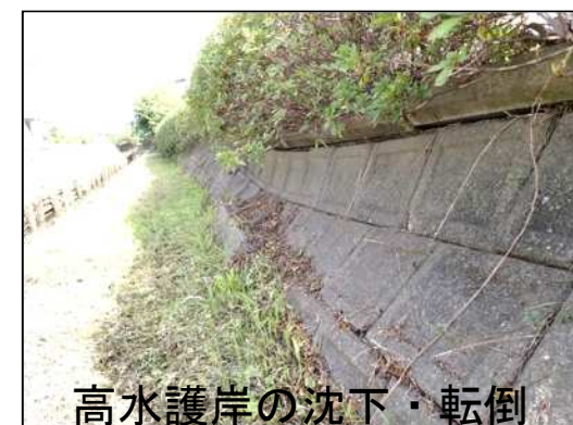
高水護岸の沈下・はらみ出し
