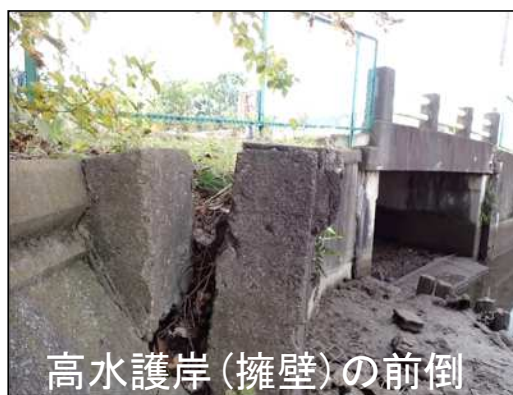
高水護岸の沈下・はらみ出し
