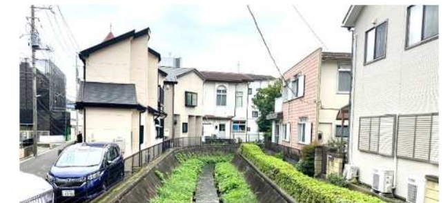
導水路両岸に家屋が近接
