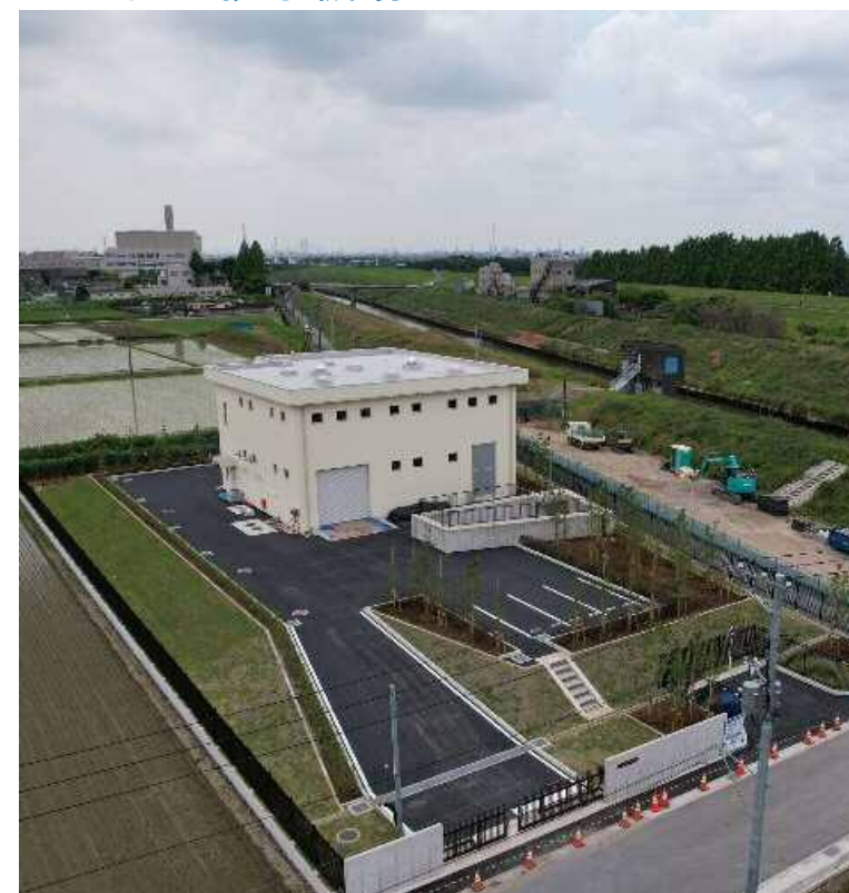
▼油面川排水機場
