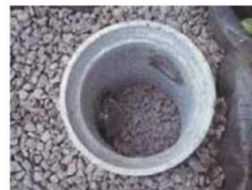
雨水浸透ます
