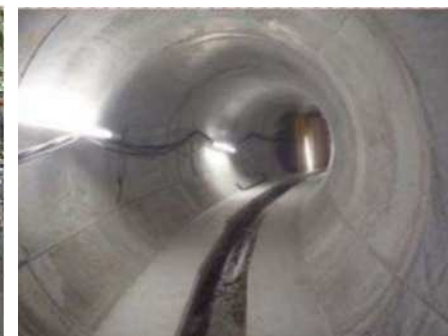
写真2 丸子その1雨水幹線（管内）
