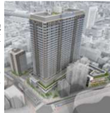
大宮駅西口第3-B地区 (竣工イメージ)
