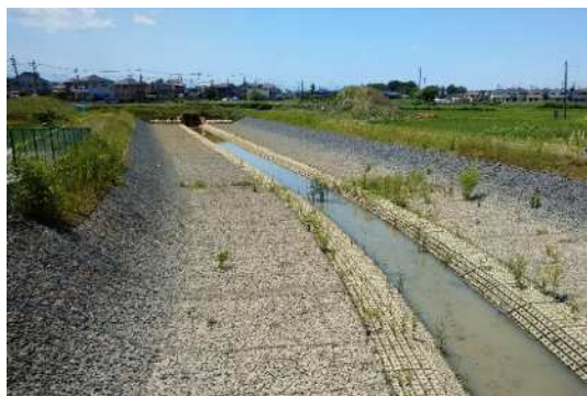
図 5 3 準用河川新川改修事業 （多自然川づくり） 植生によって被覆される資材を使用
