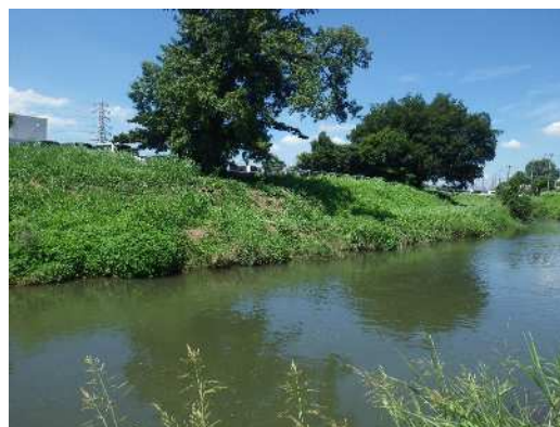
単調な河川環境（妙見橋）
