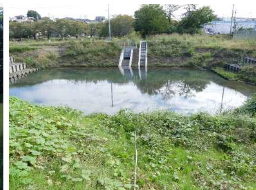
橋の付替え工事に伴い造成された環境（境橋）
