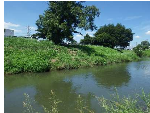
護岸されていない川岸（妙見橋）
