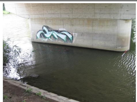
定置網（設置状況）
