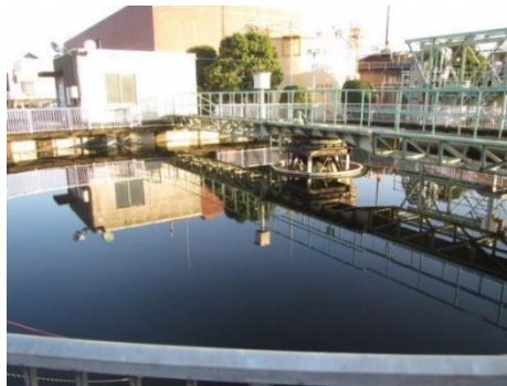
【下水処理センター処理水（最終沈殿池）】
