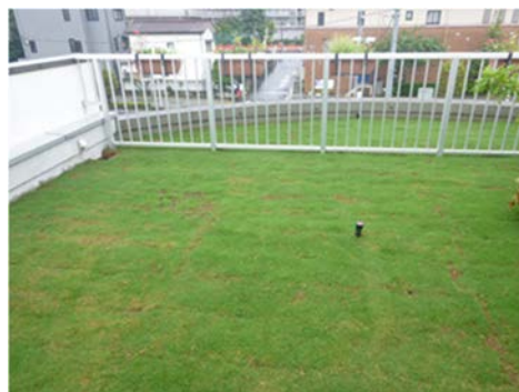
屋上緑化の様子
