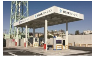
＜浦和水素ステーション(桜区)＞
