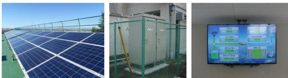
図 48 市立学校に設置した太陽光パネル、蓄電池及び発電情報モニター
