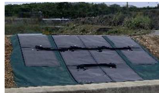
防草シートへの設置
