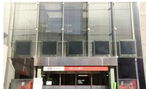
カーテンウォール 室内側
