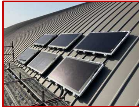
体育館屋根（アーチ型）
