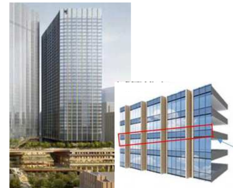
高層ビル スパンドレル部
