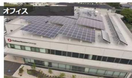
大和ハウス佐賀ビル（2018年、Nearly ZEB）
