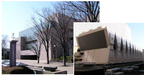
写真 さいたま市文化センターと高効率ヒートポンプ
