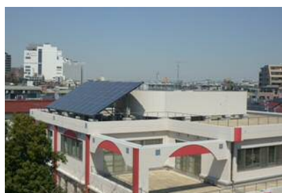
▲太陽光発電設備を設けた浦和消防署日の出出張所
