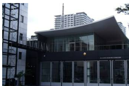
▲新設時に太陽光発電設備や雨水再利用設備を設けた大宮消防署氷川参道出張所
