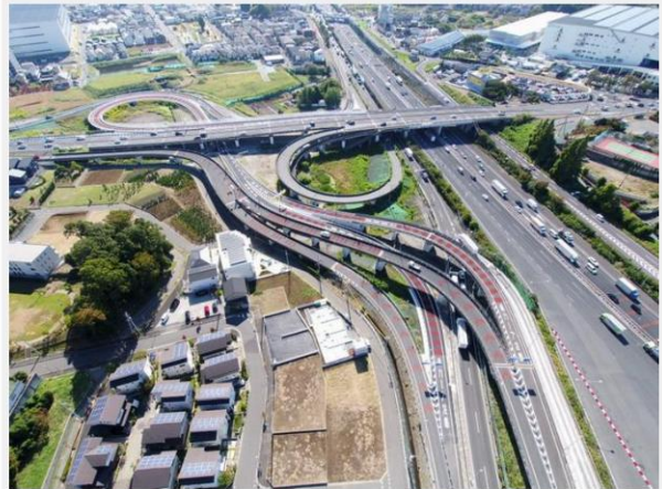
東側（D、I、G）ランプ完成状況（南向き）（令和5年10月時点）
