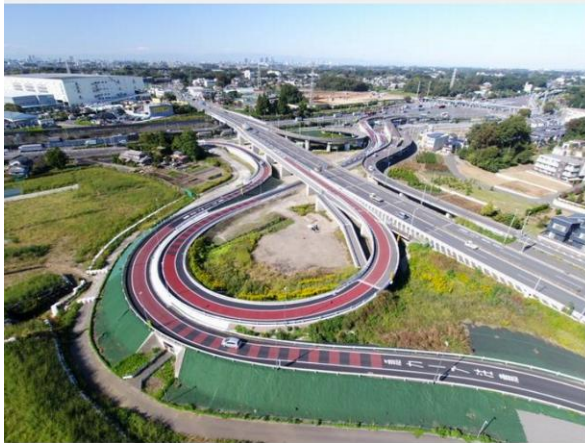
東側（D、I、G）ランプ完成状況（北西向き）（令和5年10月時点）
