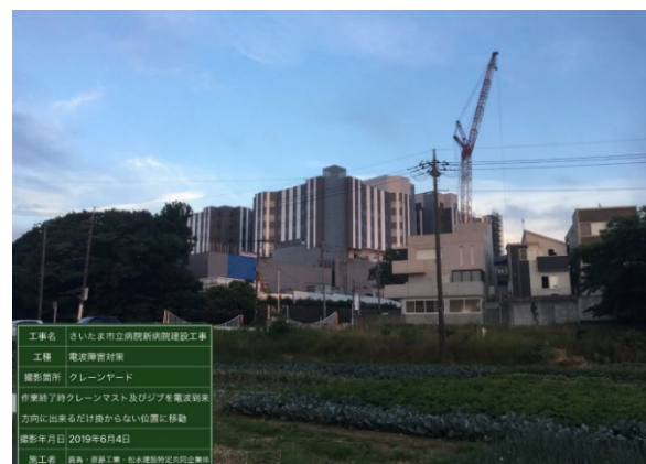
写真 1：計画地北西側から見たクレーンの状況
