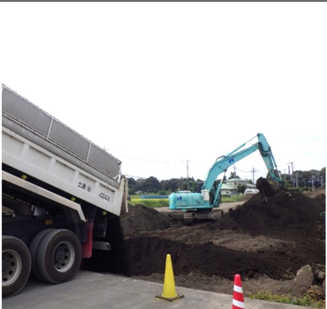
写真 4.11.1 埋戻し作業状況
