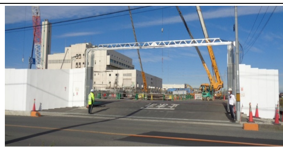
写真 4.13.1(2) 交通誘導員の配置状況
