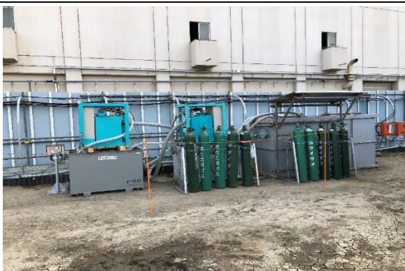
写真 4.4.1 仮設沈砂池の設置状況
