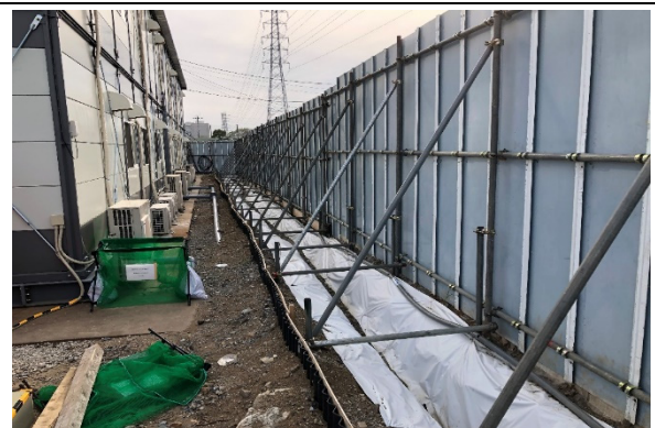
写真 4.4.2 仮設水路の設置状況
