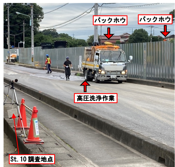
写真 4.3.2 バックホウと関係作業の状況
