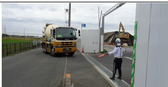
写真 4.13.1(1) 交通誘導員の配置状況
