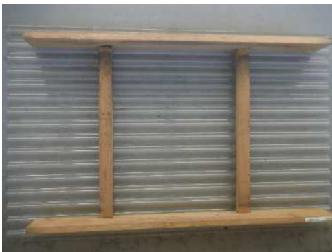
③釘等でポリカ波板と板・角材を固定する
