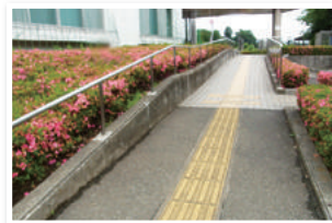
▲館内へのスロープ
