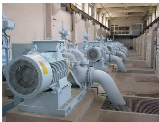
西部配水場配水ポンプ室
