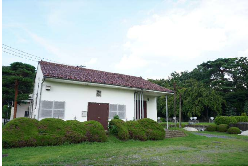
東浦和浄水場
