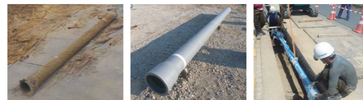
▲古い管 ▲新しい管 ※地震に強い管 ▲工事の様子 ※腐食を防ぐための対策をして、管を埋めています。
